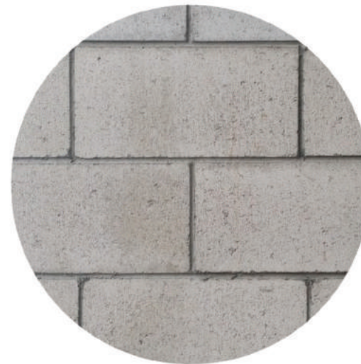
BETONMETSSELWERK (VASTE WANDEN)
