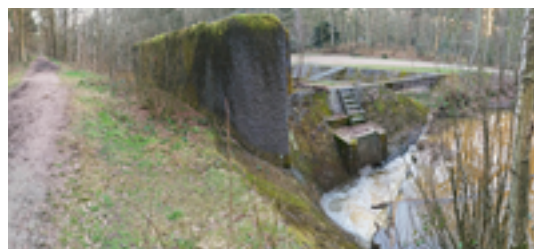
Afbeelding 8: SLUISBUNKER (MET OVERLOOP) in het midden van de antitankgracht
