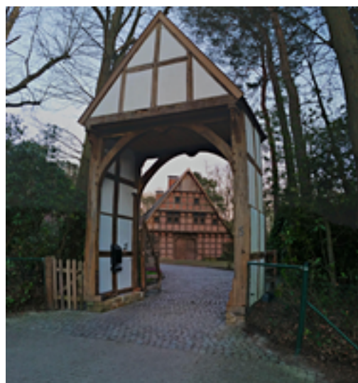
Afbeelding 23: Inrijpoort oud gebouw
